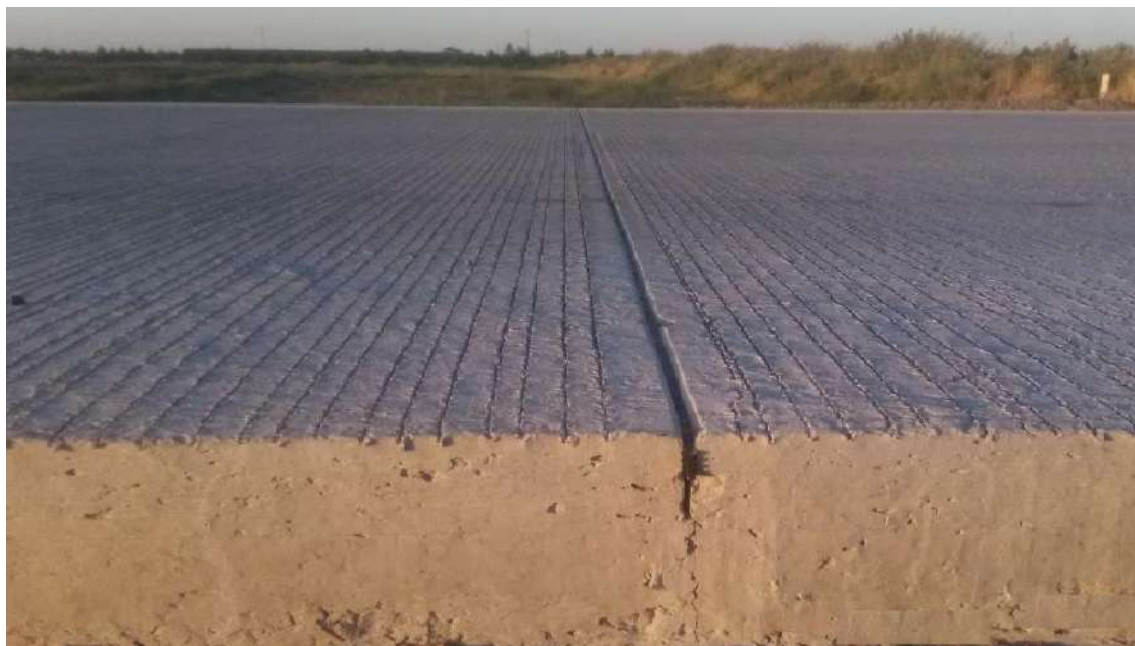
2-rasm. Ko'ndalang siqilish choki ishlab ketgandan keyingi ko'rinish (G'uzor-Buxora-Nukus-Beynov yo'li 262-km bo'lagi).
