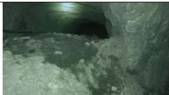
Рис.1.4. Достигнутый контур выработки сечением 7,8 м 2 при действующем паспорте БВР на руднике Каракутан.
