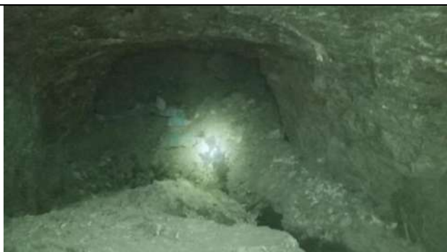
Рис.1.1. Достигнутый контур выработки сечением 10,36 м 2 при промышленных испытаниях по предложенной методике расчета паспорта БВР.
