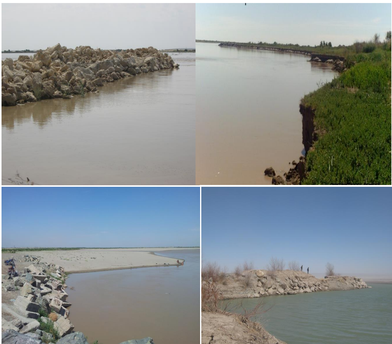
Расм 1. Амударёнинг Хоразм вилояти ҳудудидан оқиб ўтувчи қисмида “дейғиш” кузатилиши, шпора ва дамбалар кўриниши.
