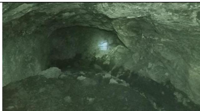
**Рис. 1.2. Достигнутый контур выработки сечением 10,36 м<sup>2</sup> при действующем паспорте БВР на рудники Каракутан.**
