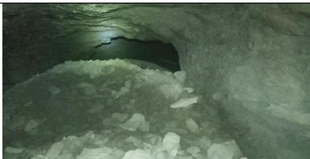
**Рис.1.3. Достигнутый контур выработки сечением 7,8 м<sup>2</sup> при промышленных испытаниях по предложенной методике расчета паспорта БВР.**
