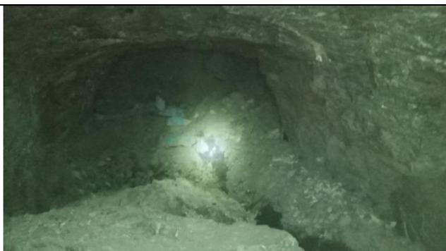
**Рис.1.1. Достигнутый контур выработки сечением 10,36 м<sup>2</sup> при промышленных испытаниях по предложенной методике расчета паспорта БВР.**
