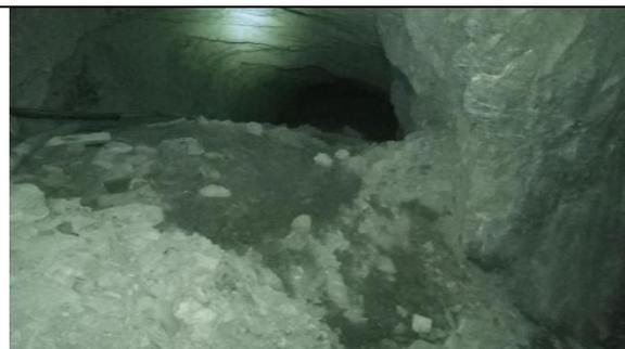
**Рис.1.4. Достигнутый контур выработки сечением 7,8 м<sup>2</sup> при действующем паспорте БВР на рудники Каракутан.**
