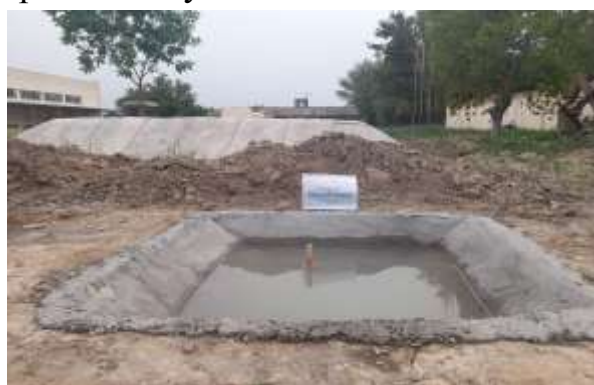
6-расм. Бетонли каналнинг эксперимент кўриниши.
