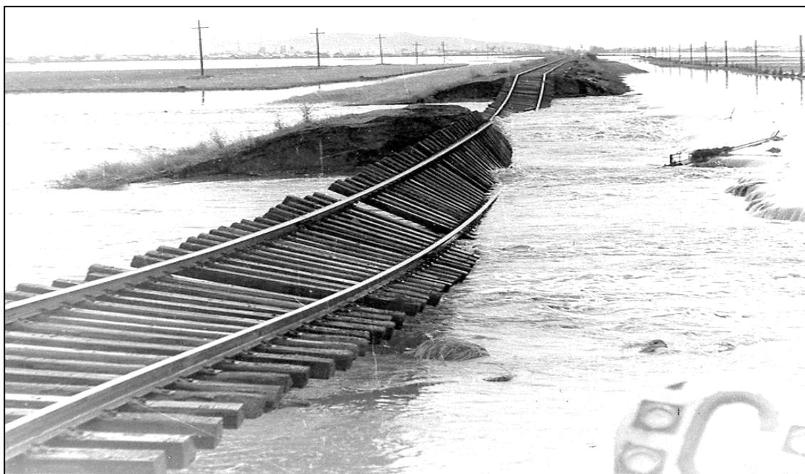
***Рис. 1. Размыв железнодорожного пути на перегоне***
